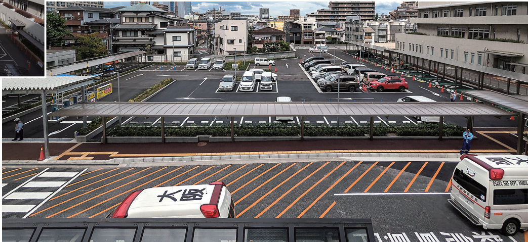
復旧後駐車場(全体)▶
