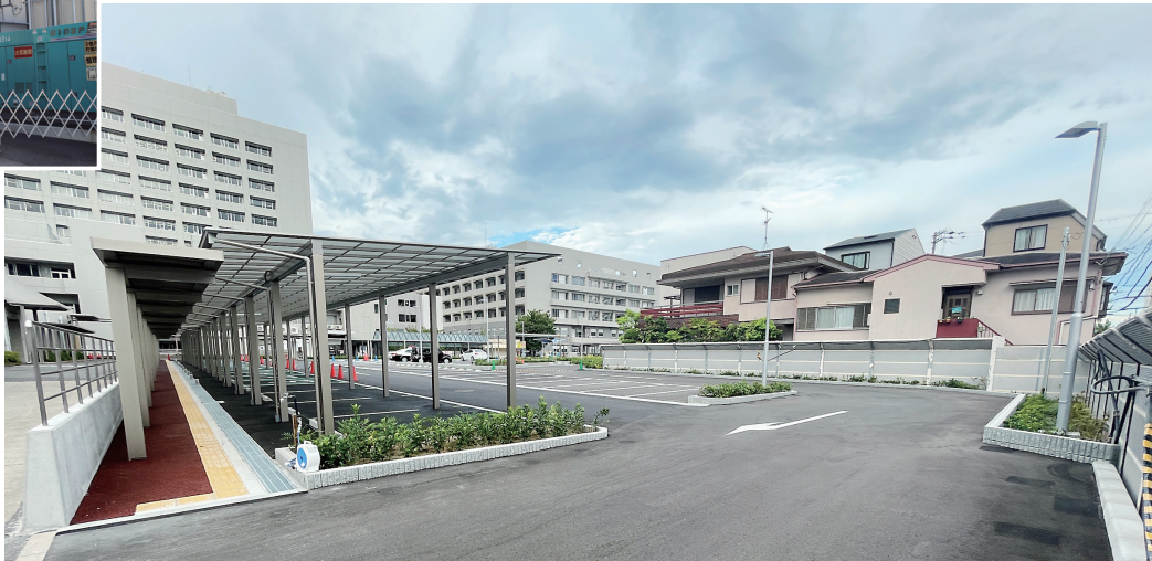
復旧後駐車場▶
