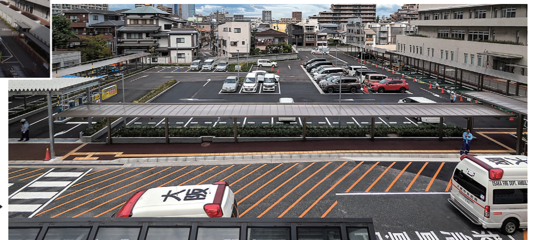
復旧後駐車場(全体)▶
