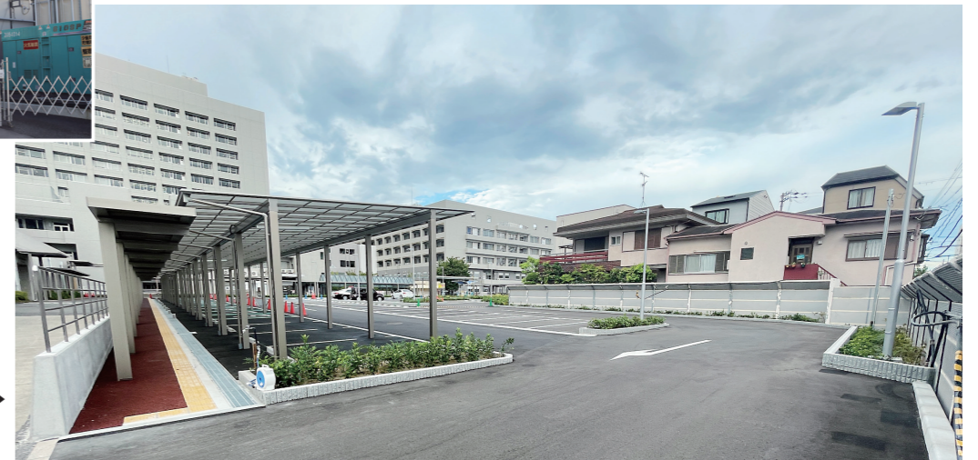
復旧後駐車場▶
