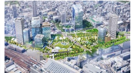
うめきた2期地区開発のイメージ 提供:うめきた2期開発事業者 2022年5月時点のイメージパースであり、 今後変更となる可能性があります
