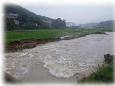
平成30年7月豪雨 河川増水による護岸の崩壊
