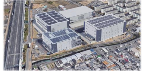
第二京阪道路沿道：門真市北島東地区
