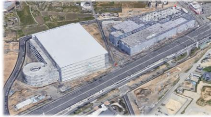
第二京阪道路沿道：交野市星田北地区
