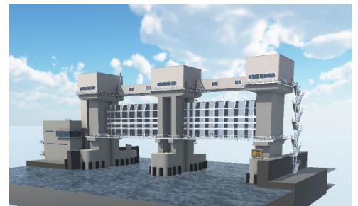
新木津川水門完成イメージ 出典：大阪府
