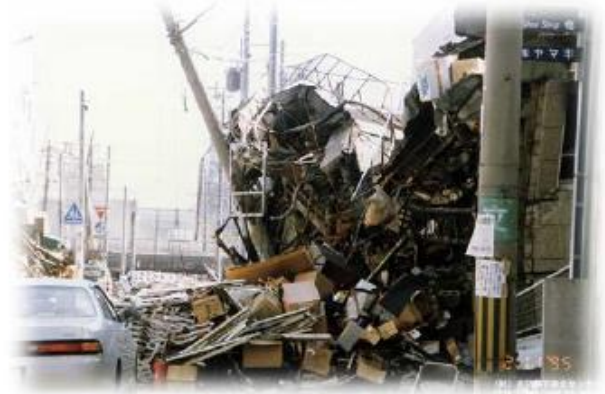
【阪神・淡路大震災 建物被害と道路閉塞】
