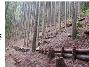
本数調整伐と筋工の施工
