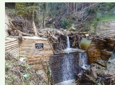
治山ダムによる 土砂・流木の捕捉
