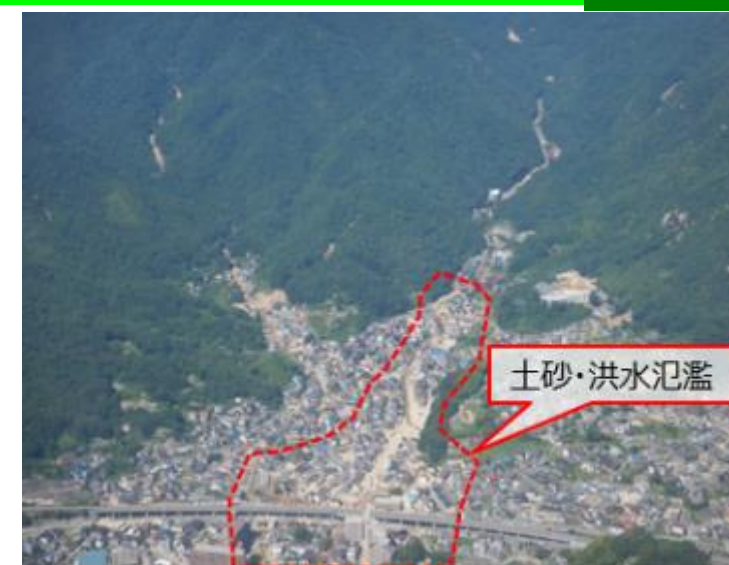
土砂・洪水氾濫の発生事例(広島県呉市)
