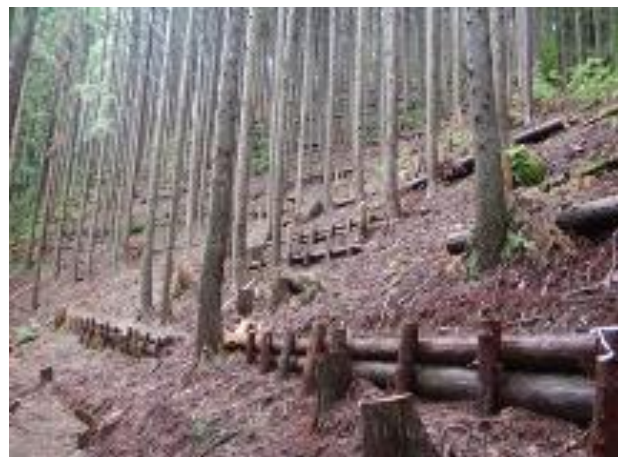
本数調整伐と筋工の施工
