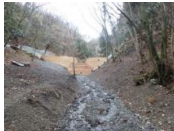
溪流沿いの危険木の除去
