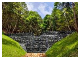
土砂流出を抑制する治山ダム
