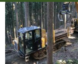
遠隔操作の運搬機械
