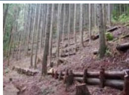
保水力向上のための間伐・筋工
