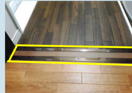
洗面所入口 敷居 段差解消工事
