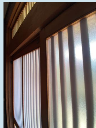
玄関扉F ガラスを アクリル 板に入替
