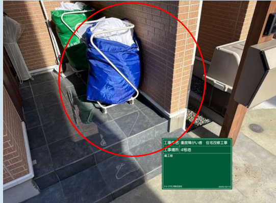
手すり設置工事
