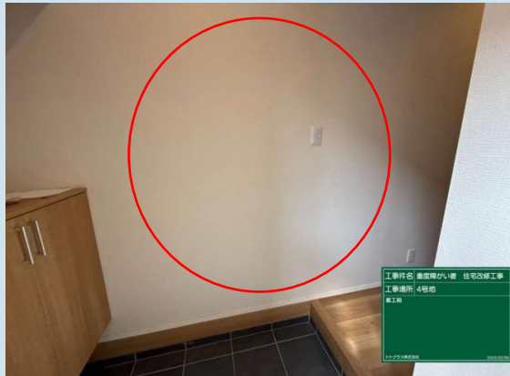
手すり設置工事
