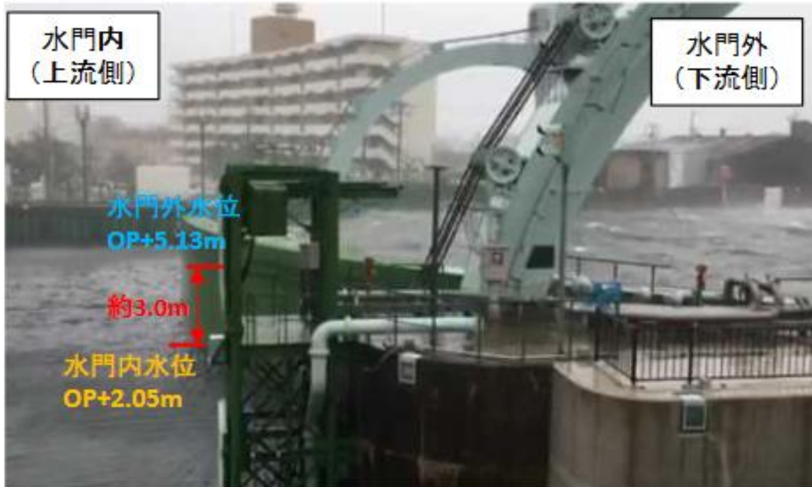
水門閉鎖後における木津川水門
