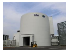
■ 多目的大型実験棟
