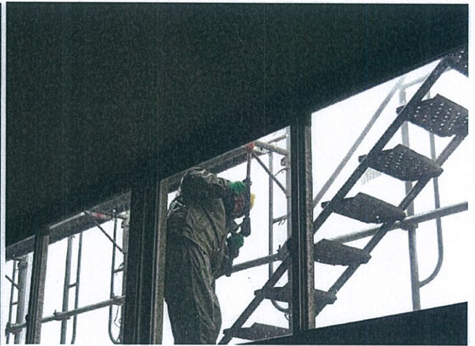
写真VII-2. 4階 足場上での高圧洗浄作業2
