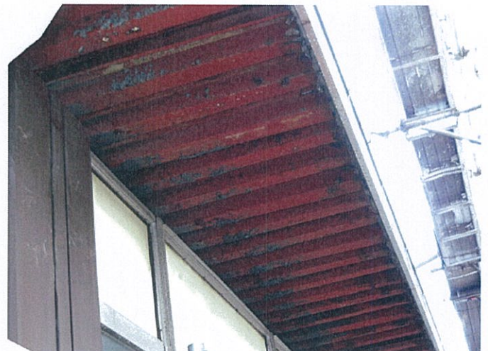
写真IX. 4階 軒裏の様子
