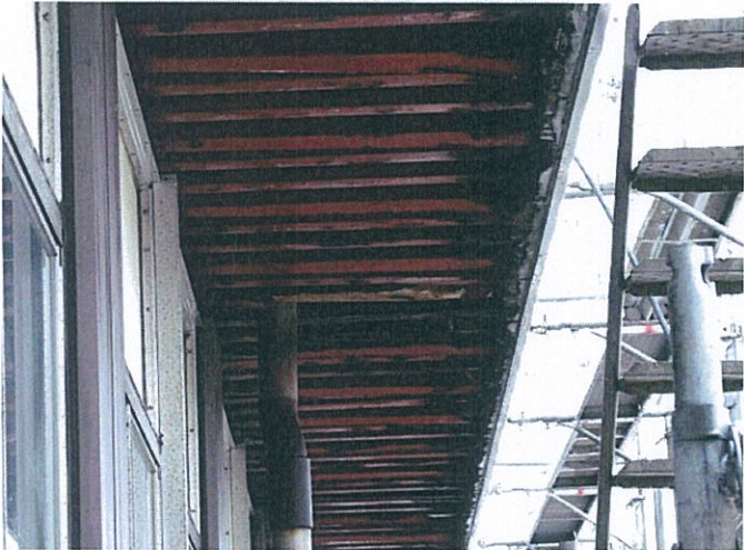
写真VIII. 4階 軒裏の様子(洗浄作業場周辺)
