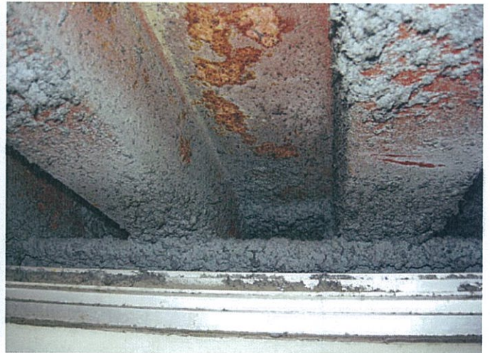
写真Ⅱ. 軒先から校舎内部方向
