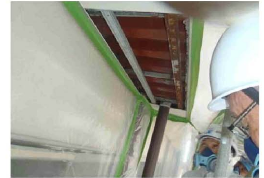
測定点1-1付近 ボード撤去後
