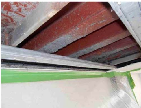
測定点2-3付近 ボード撤去後
