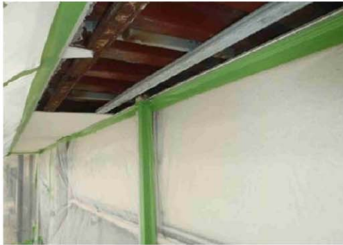
測定点1-2付近 ボード撤去後
