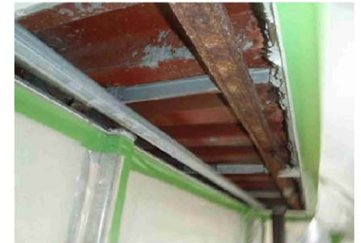
測定点1-2付近 ボード撤去後
