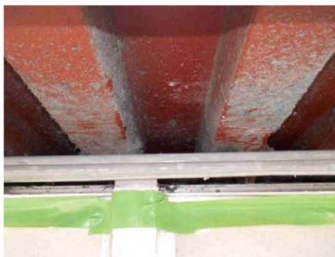
測定点2-3付近 ボード撤去後
