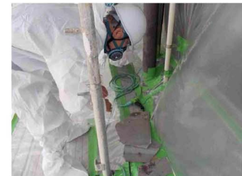
測定点2-1付近 ボード付着物確認
