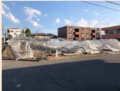
ハウスの被害(堺市)
