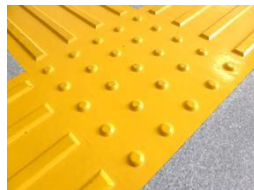
■ 警告ブロック
