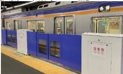
難波駅 (高さ：約 1.3m、最大開口：約 3.5m)
