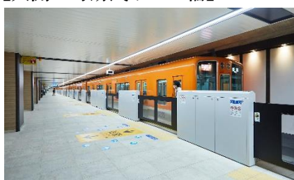
大阪梅田駅 (高さ：約 1.4m、最大開口：約 3.6m)
