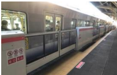
京橋駅 (高さ：約 1.3m、最大開口：約 3.5m)
