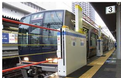
大阪駅 (高さ：約 1.3m、最大開口：約 13m)
