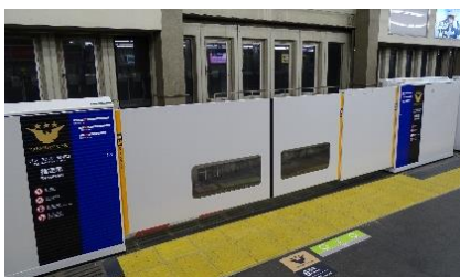
京橋駅 (高さ：約 1.3m、最大開口：約 4.5m)
