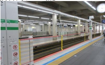
大阪阿部野橋駅 (高さ：約 1.3m、最大開口：約 13m)
