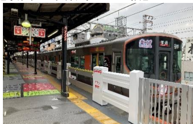
西九条駅 (高さ：約 1.1m、最大開口：約 3.5m)
