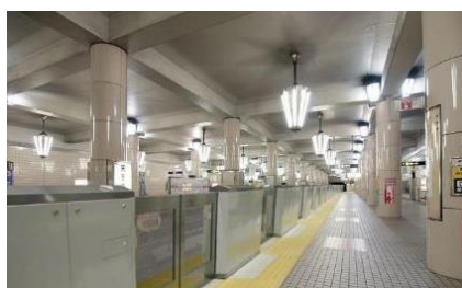
天王寺駅 (高さ：約 1.3m、最大開口：約 2.6m)
