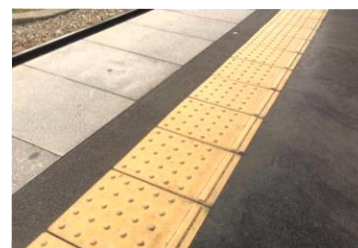
(内方線付き点状ブロック)
