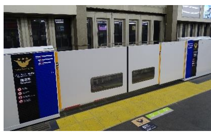
京橋駅 (高さ：約 1.3m、最大開口：約 4.5m)
