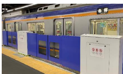
難波駅 (高さ：約 1.3m、最大開口：約 3.5m)
