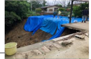
河内長野市清水 法面崩壊
