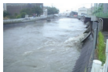
雨水ポンプ場排水状況（新家ポンプ場 橋筋川）
