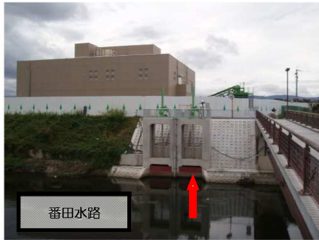
現地写真【安威川左岸ポンプ場：流入渠】
