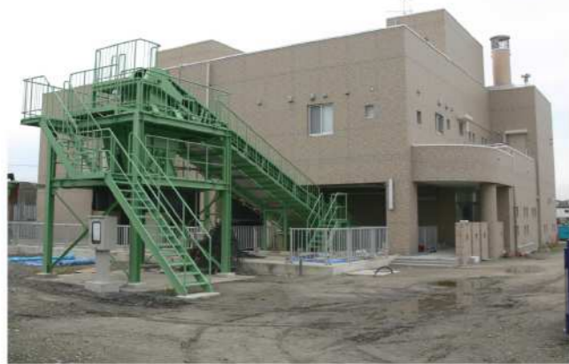
現地写真【安威川左岸ポンプ場：管理棟】
