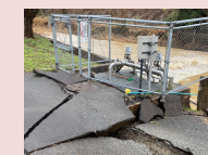
水道の復旧（被災した浄水場）
