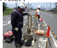
（貫入試験による調査）
