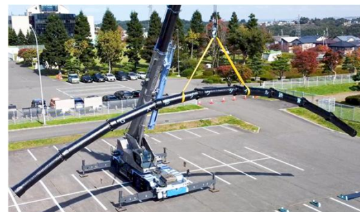
耐震型ダクタイル鉄管採用50周年セミナー (新耐震管GXφ500吊り上げ)
