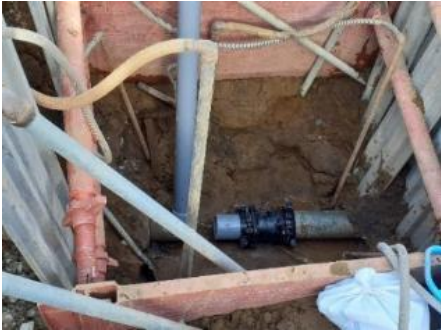
【応急復旧状況】
