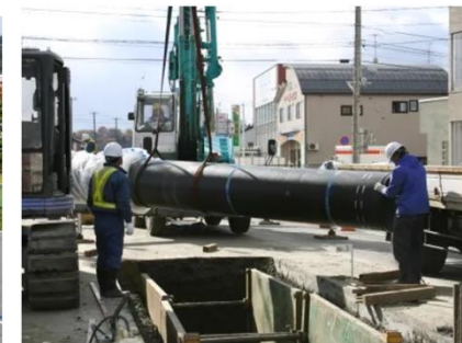
耐震管の布設工事
