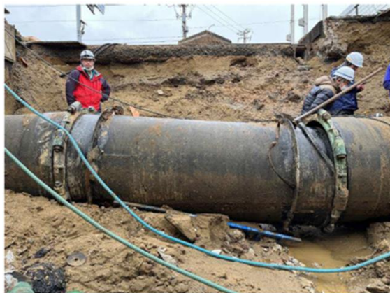
能登半島地震での被害（送水管、浄水場）
