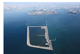
大阪沖処分場
