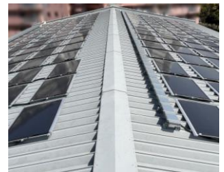
福岡市立香椎浜小学校(体育館屋根)
