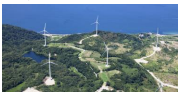
あわじ 淡路風力発電所 (関電エネルギーソリューション)
