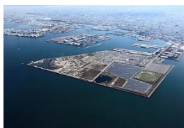
泉大津沖処分場
