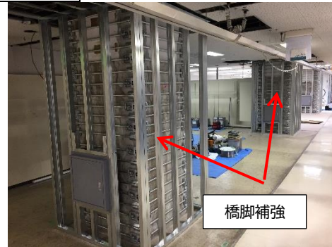
高架駅の耐震対策(橋脚補強)
