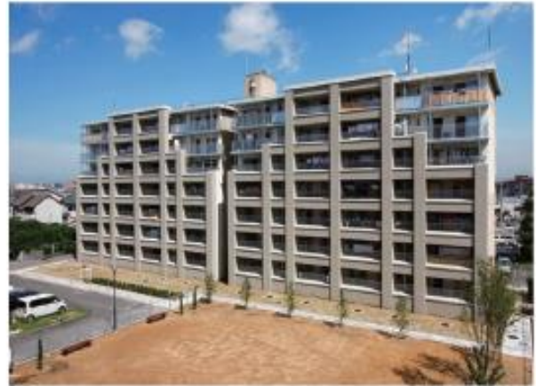
【府営住宅】深井中町住宅(Pca アウトフレーム工法)
