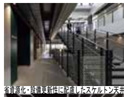
省資源化・設備更新性に配慮したスケルトン天井
