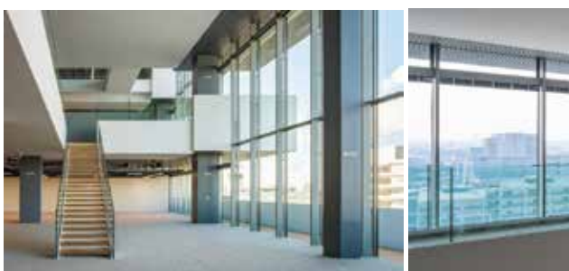
奥行のある方が縦ルーバーとして働き、欄間窓が開閉。天井ルーバーが風景や照明を柔らかく反射する。
