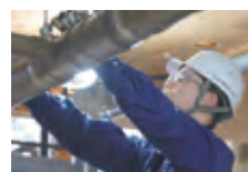
給排水設備施工実習
