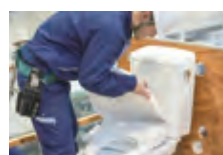
衛生機器取付実習
