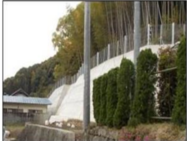
急傾斜崩壊対策の取組状況 (擁壁工の整備)
