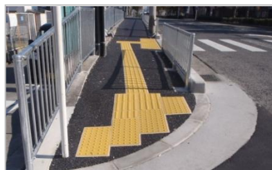
視覚障がい者誘導用ブロック設置 大堀堺線（松原市）
