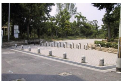
出入口の改修
