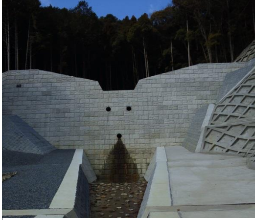
土石流対策の取組状況 (砂防えん堤の整備)
