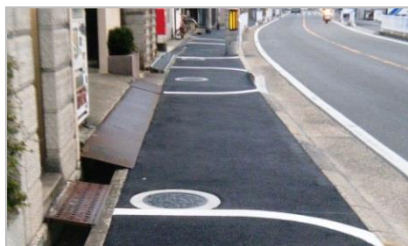
段差、勾配の改善 大阪八尾線（東大阪市）
