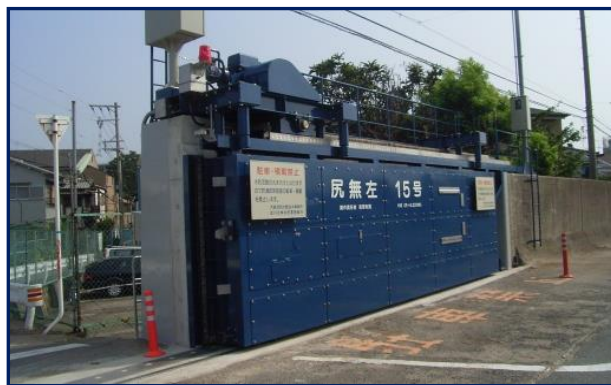
【鉄扉の電動化】平成 26 年度完了
