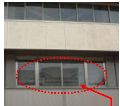
大阪府庁舎別館の耐震改修 （柱・壁の鋼板補強と制振装置設置）
