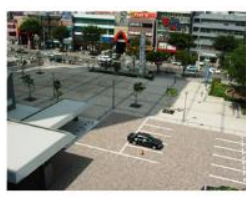
透水性・保水性舗装
