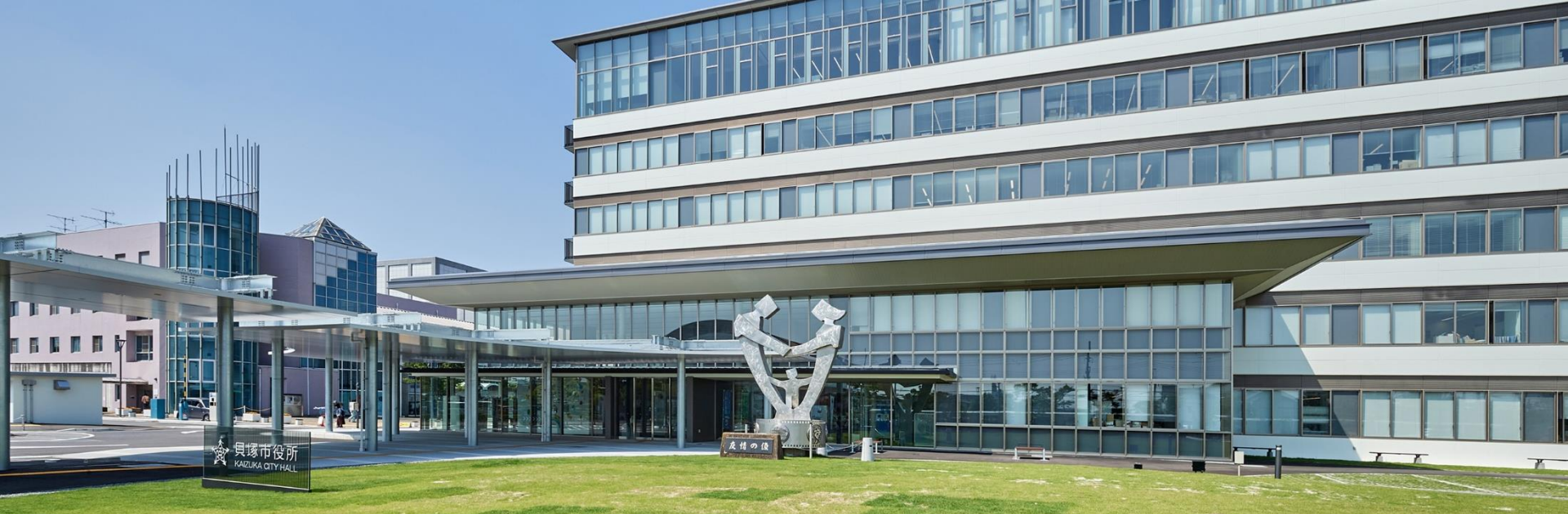
平地で伸びやかな景観に合わせ、水平ラインを強調した大庇・キャノピーを使った外観
