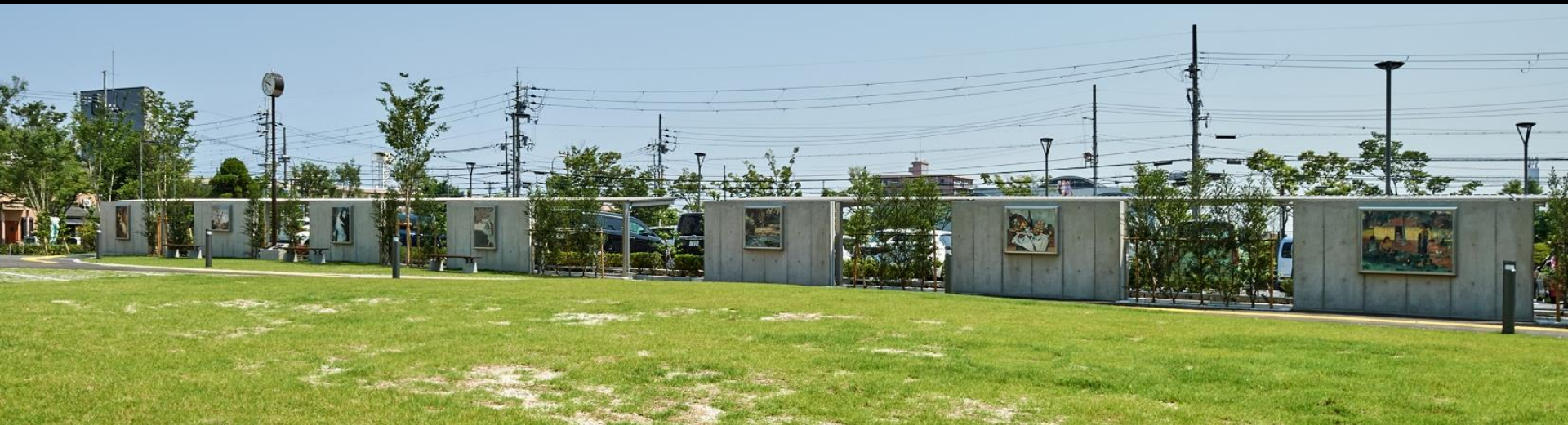
従前の庁舎より引き継いだモニュメント等を設置
