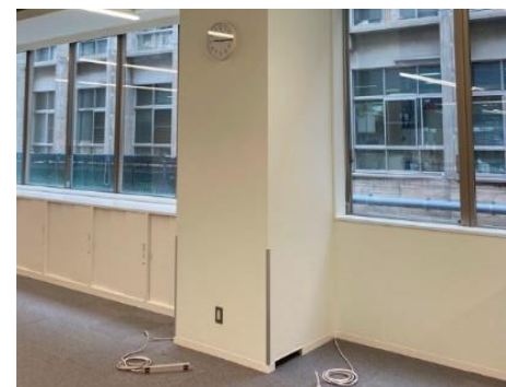
北面窓では冬期の冷気を巾木から回収
