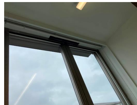
南面窓では夏期の暖気をブラインドボックスから回収
