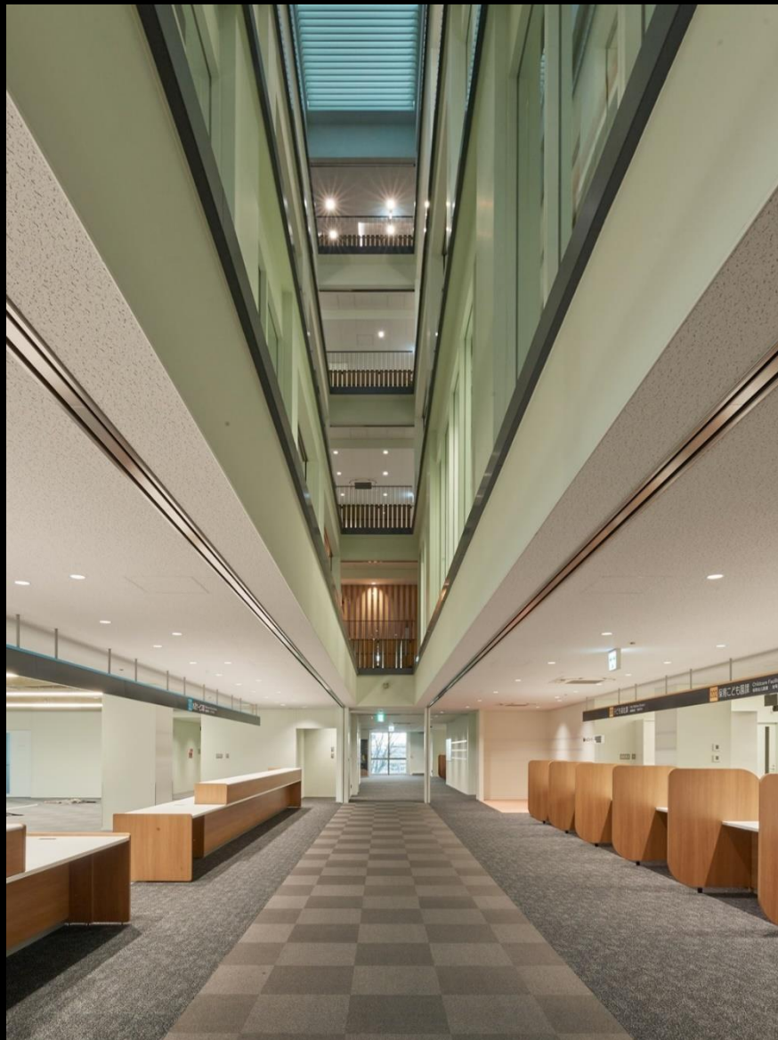
エコシャフトによる自然光・自然換気の入
