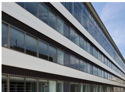
Low-e複層ガラスによる日射を抑制
