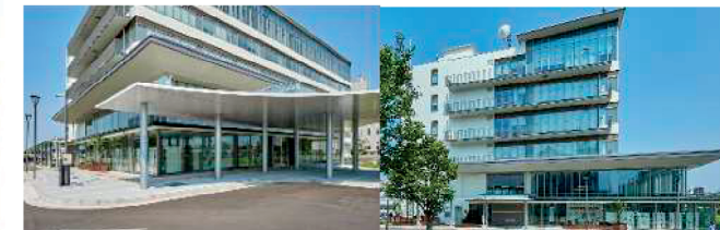
日陰をつくる大庇とキャノピー
