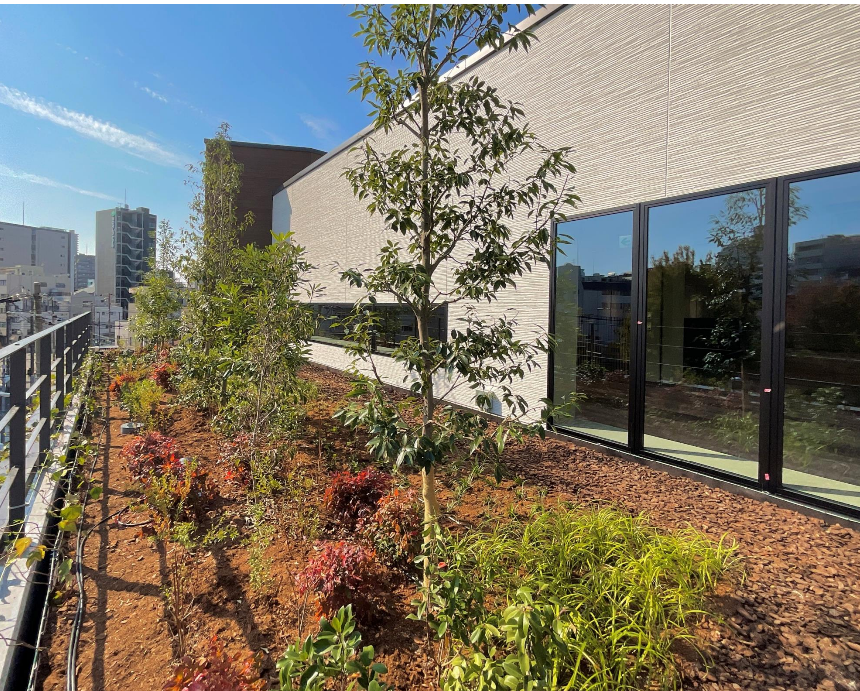
3階休憩スペース前の屋上緑化
