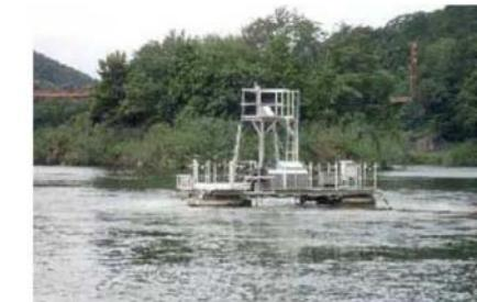
写真 6.1-2 浅層曝気循環設備（室生ダム）
