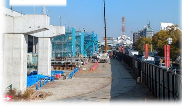
支柱建設工事
