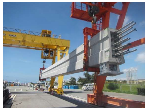
型枠を外した軌道桁
