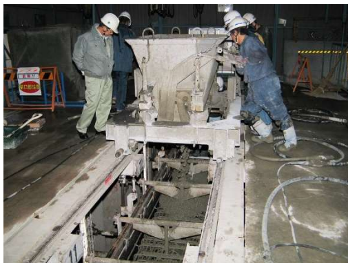
型枠へのコンクリート打込み
