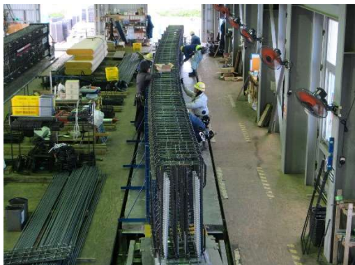
鉄筋の組み立て
