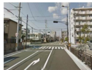
広幅員道路整備
