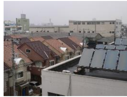
住工共生が進む高井田地域(東大阪市)
