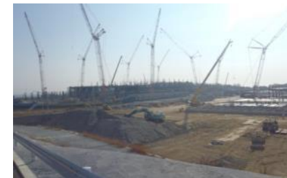
施設建築状況
