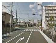
広幅員道路整備
