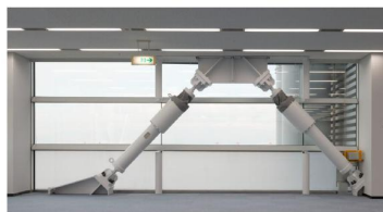
府有建築物の耐震化 (咲洲庁舎 耐震ダンパー)
