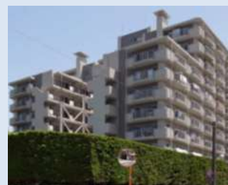
耐震改修済み
