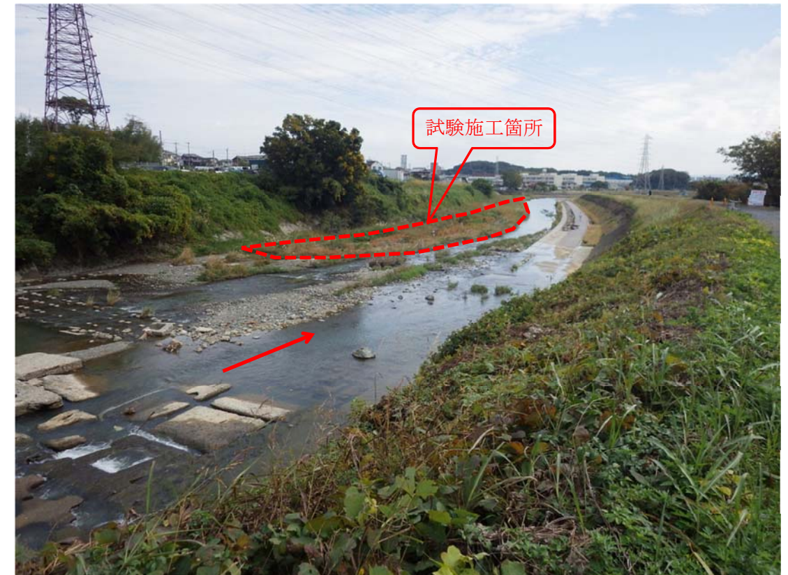
是推橋下流の落差工(14.9k 付近)から下流に堆積した砂州(植生が繁茂)
