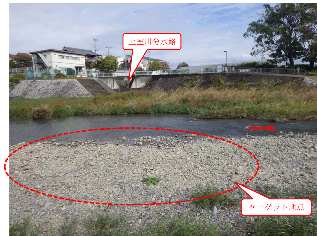
土室川分水路合流点（14.6k 付近）に堆積した砂州（ターゲット地点）
