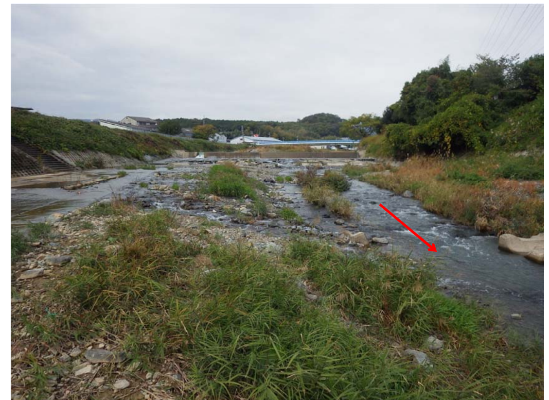
是推橋下流の落差工(14.9k 付近)から下流に堆積した砂州より上流を望む
