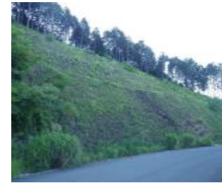
安威工区①の法面
