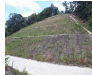
生保工区①の法面
