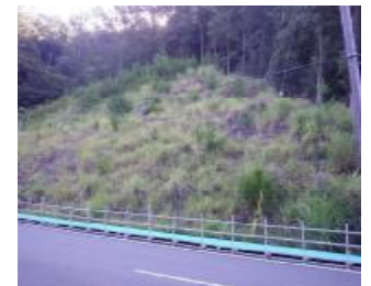
車作工区①-1の法面
