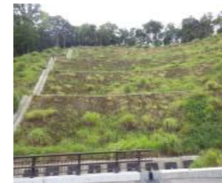
生保工区⑥の法面
