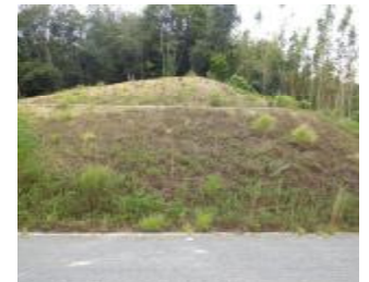
生保工区④の法面
