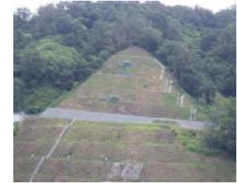
安威工区⑤の法面
