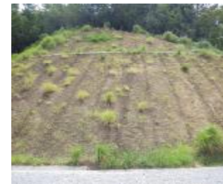
生保工区⑤の法面
