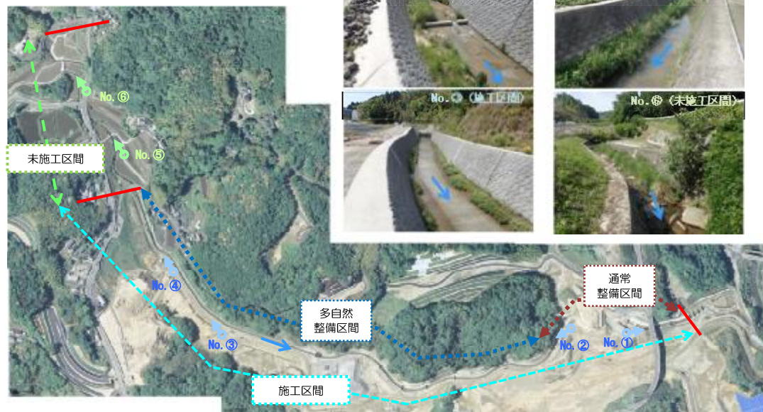
図 2.2-1 生物生育・生息環境の多自然河川整備（大岩川付替工事）概要
