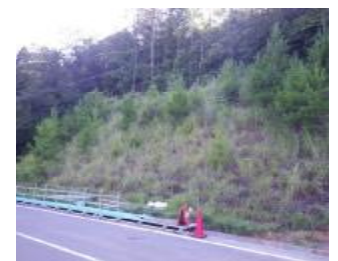
車作工区③の法面
