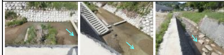
施工区間の環境保全対策工の現況
