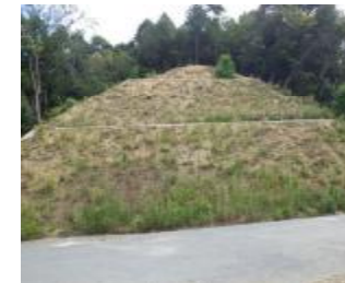
生保工区②の法面
