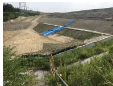
裸地の緑化工 (大岩地区建設発生土受入地)
