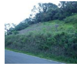
安威工区②の法面
