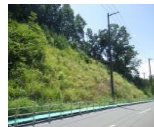
車作工区①-2の法面
