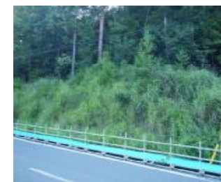
車作工区②の法面
