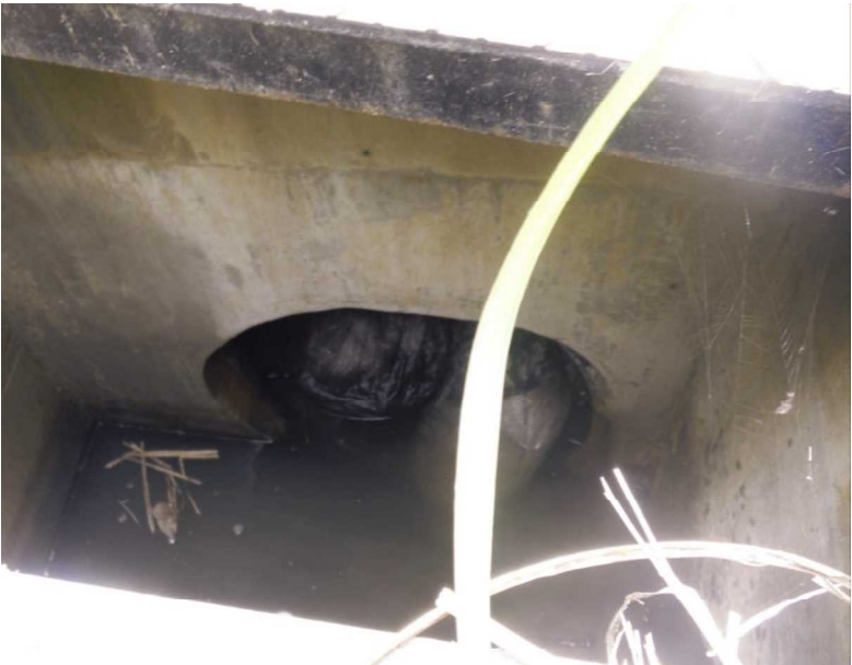
モルタル打設前（土のうにより水位を調整）
