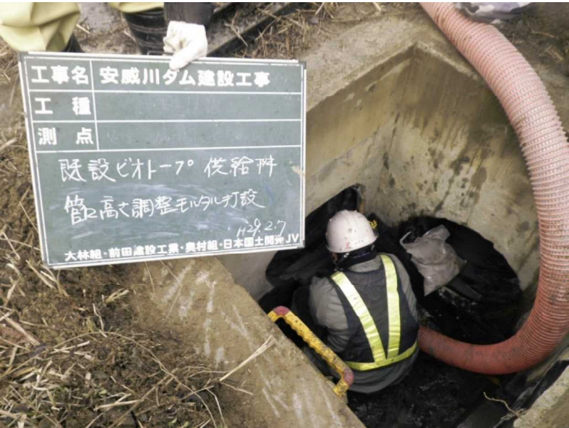
給水用桝管底高さ調整モルタル打設状況
