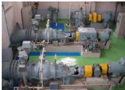
整備前の機場の様子
