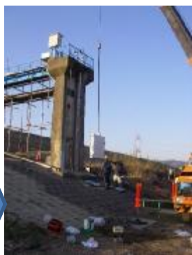
取水ゲート補修の様子
