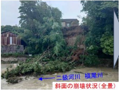
斜面の崩壊状況(全景)
